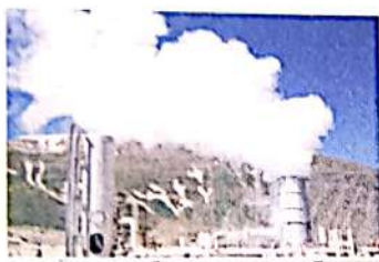
شکل ۱۲- نیروگاه زمین گرمایی مشکین شهر که با توان تولیدی ۱۰۰ مگاوات نصب شده است.
