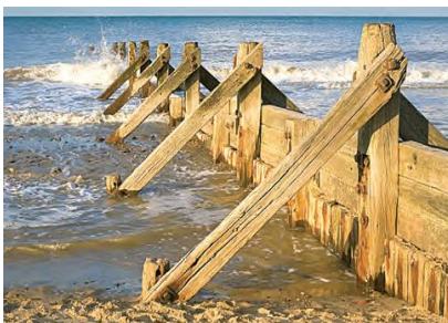
نصب حفاظ عمودی
