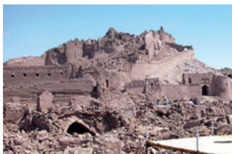
ارگ بم، بزرگ‌ترین سازه خشتی جهان در زلزله بم دچار تخریب زیاد شد.
