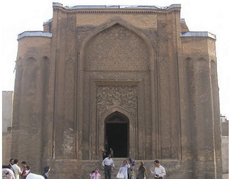
گنبد علویان از بناهای دوره سلجوقی - همدان
