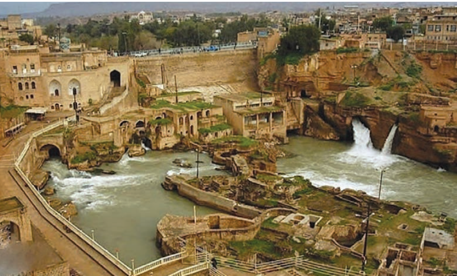
شکل ۵- سازه‌های آبی - تاریخی، شوشتر، خوزستان
