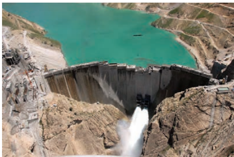
شکل ۵- سد کارون (۴) - خوزستان
