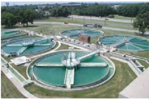
تصفیه آب در تصفیه خانه
