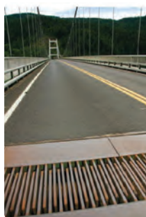
(ب) نمونه‌ای از بست‌های انبساطی
