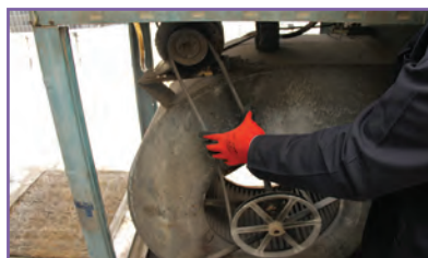
ب- بررسی وضعیت تسمه
