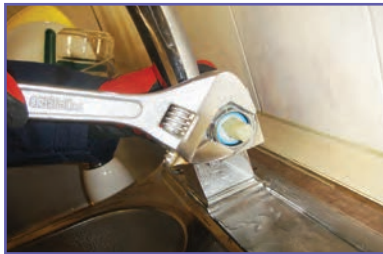
ث- باز کردن پیچ روی مغزی (گلند)
