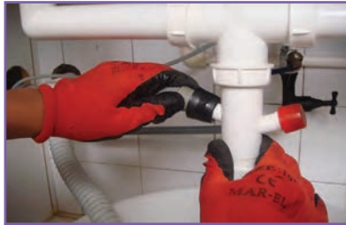
ب- جداسازی لوله پساب ماشین لباس شویی و ماشین ظرفشویی
