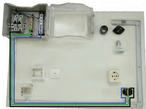
شکل ۱۰-۵- انجام سیم‌کشی پریز ۱
