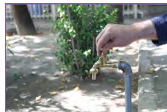
خ - آزمایش آب بندی شیر
