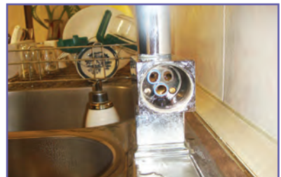
ج- کنترل نشیمنگاه
