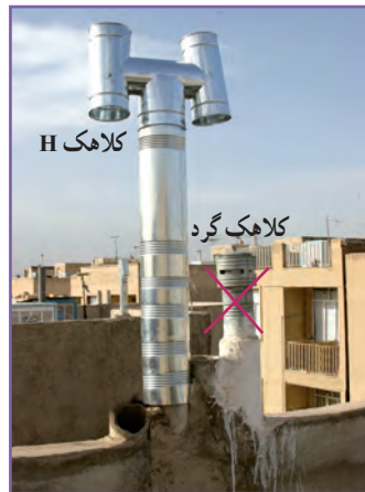
ب - فاصله بین دودکش تا کولر آبی و یا پ - برای خروجی دودکش هر دستگاه گاز سوز یک کلاهک H نصب شود. درجه های تأمین هوای ساختمان دست کم سه متر باشد.
