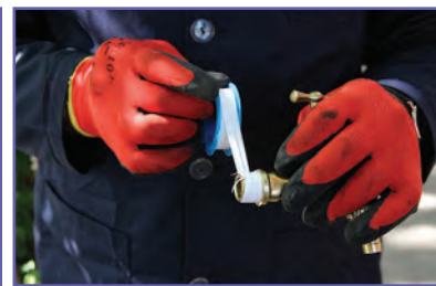
پ- پیچیدن نوار تفلون روی شیر نو
