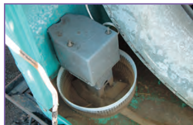
ج- بررسی و تمیز کردن پمپ آب
