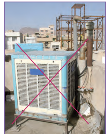
ب - فاصله بین دودکش تا کولر آبی و یا پ - برای خروجی دودکش هر دستگاه گاز سوز یک کلاهک H نصب شود. درجه های تأمین هوای ساختمان دست کم سه متر باشد.
