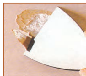
الف - باز کردن ترک‌ها
